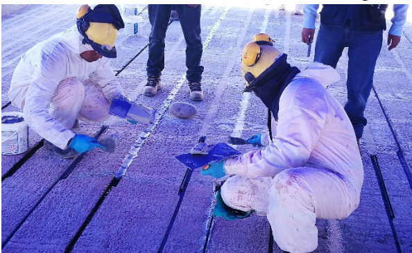
Figura 6. Proceso de colocación de barras de fibra de carbono.
