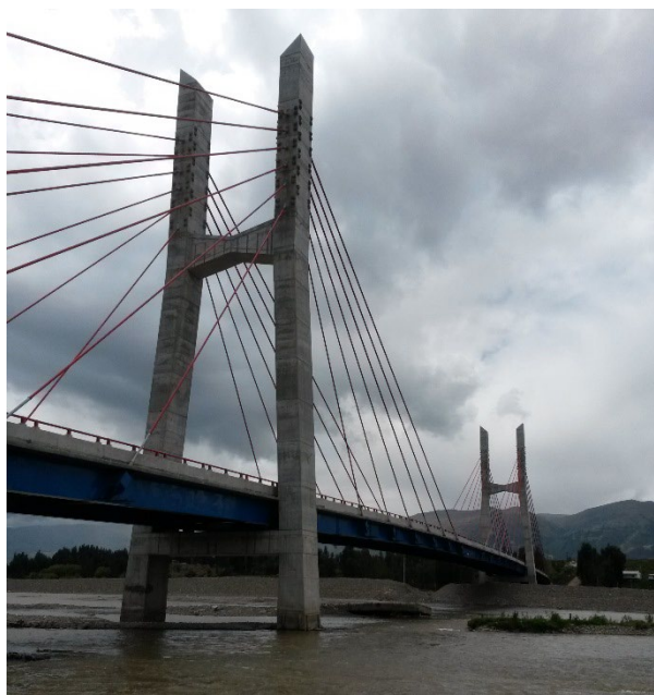
Figura 1. Vista del puente.
