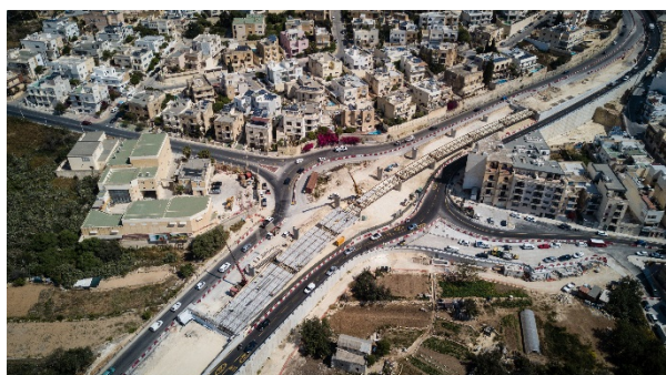
Figura 14. Vista aérea de las obras.
