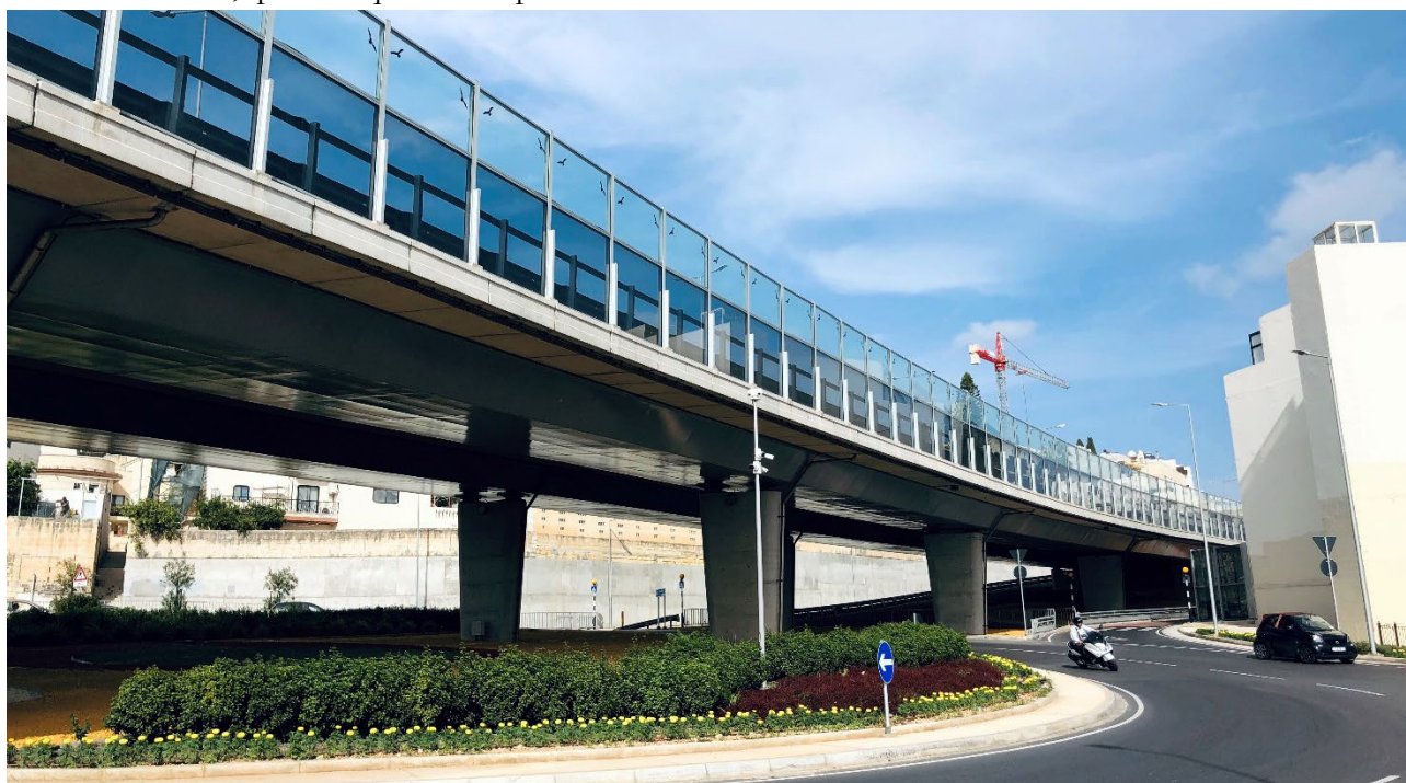
Figura 3. Vista general del paso elevado.
