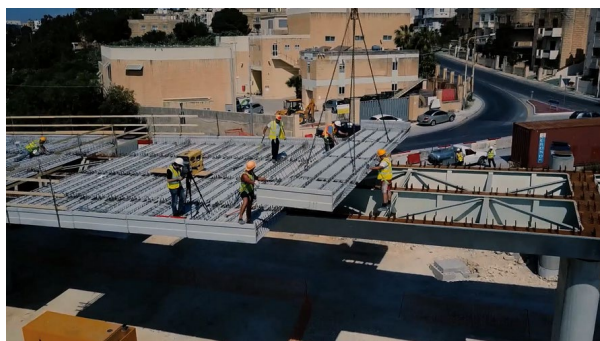
Figura 13. Colocación de prelasas.
