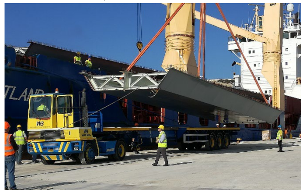
Figura 2. Desembarco de cajones metálicos
