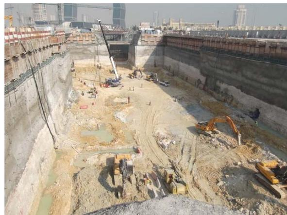
Figura 4. Excavación de una de las estaciones antes del comienzo de ejecución de la estructura, LRT-Lusail
