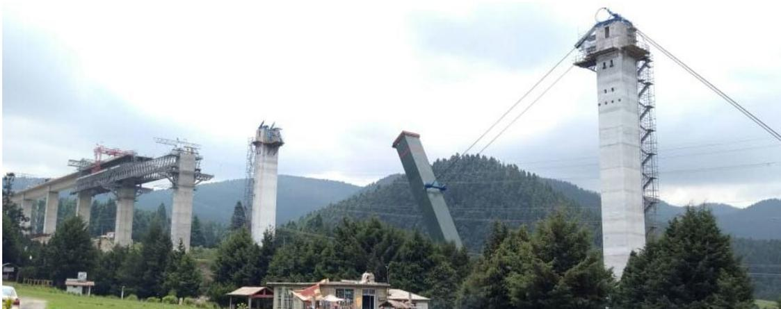
**Figura 3. Imagen general del Viaducto 4 durante el izado de uno de los fustes del apoyo 4-13**
