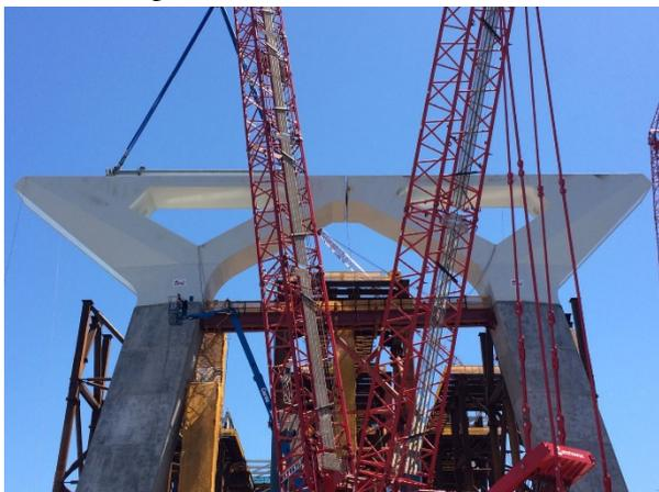
Figura 2. Pier caps sobre butts, instalación final [1].
