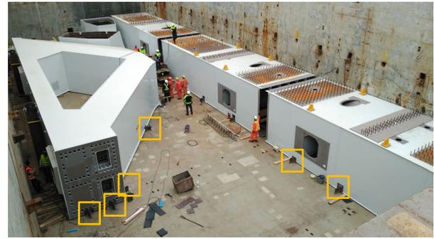
Figura 10. Topes colocados para fijación de las piezas a la cubierta del barco.
