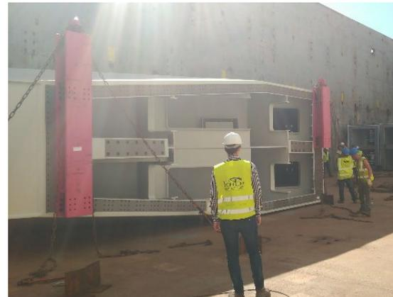
Figura 11. Colocación de cadenas y topes soldados de fijación.
