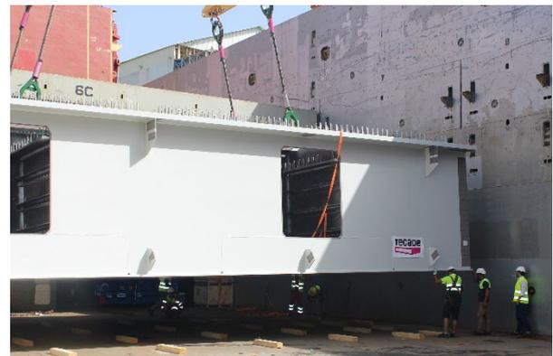
Figura 12. Apoyos de madera que reciben una pieza del tablero.
