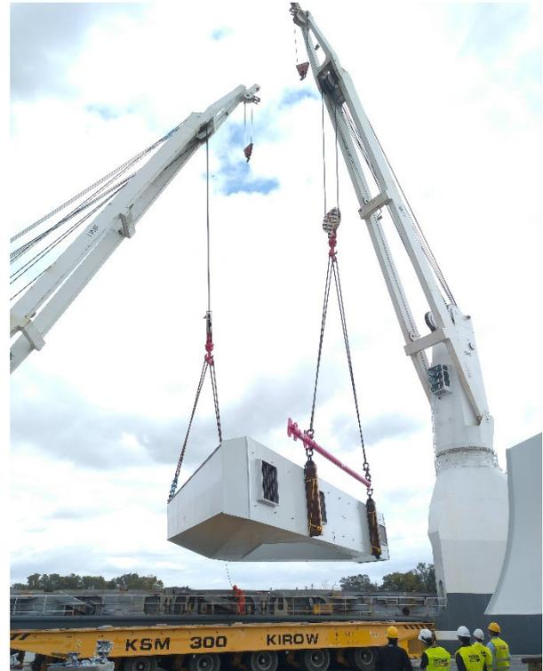
**Figura 21.** Maniobra con separador de cables en lado largo y tiro directo a cáncamo en lado corto. Empleo de un SPMT diferente.
