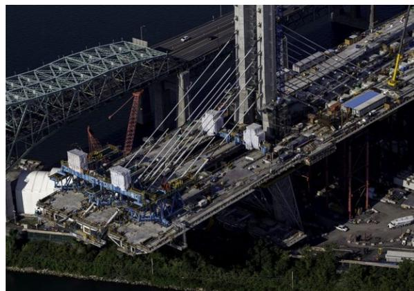
Figura 4. Vista general ejecución del tramo atirantado [1].
