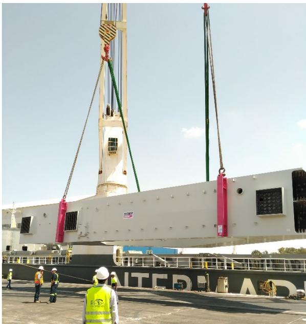
**Figura 19.** Maniobra de carga de cabecero con 2 grúas con vigas de cogida. En primer plano eslingas de acero, en verde eslingas de kevlar.
