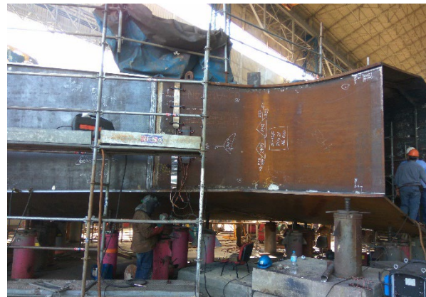
Figura 14. Soldadura del segmento inferior durante el montaje en blanco con el superior.
