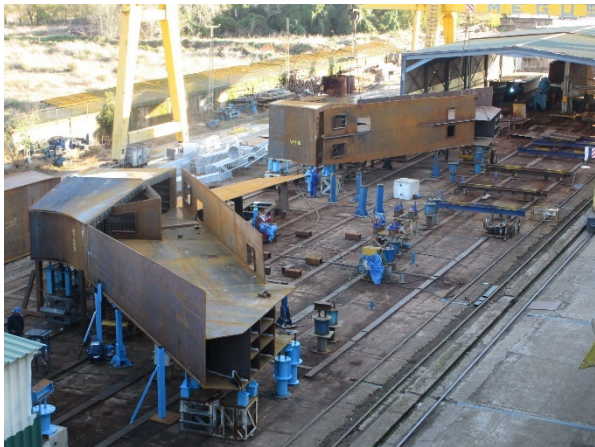
Figura 5. Montaje del dintel de pila en taller.
