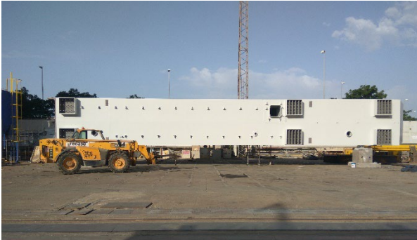
Figura 16. Vista general de uno de los dinteles de pila intercambiados.
