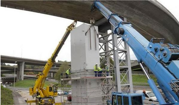
Figura 21. Instalación de tramo 3 de pila definitiva
