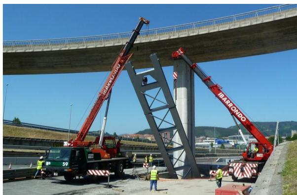
Figura 8. Montaje de estructura de apeo provisional
