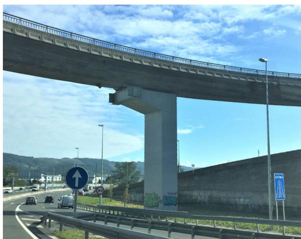
Figura 24. Pila en “C” en fase de servicio
