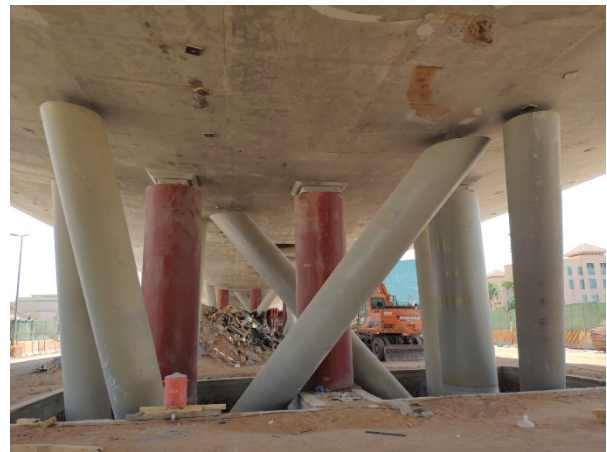
Figura 12. Pilas, proyecto en construcción.
