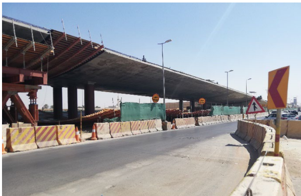
Figura 11. Vista general del puente en construcción.
