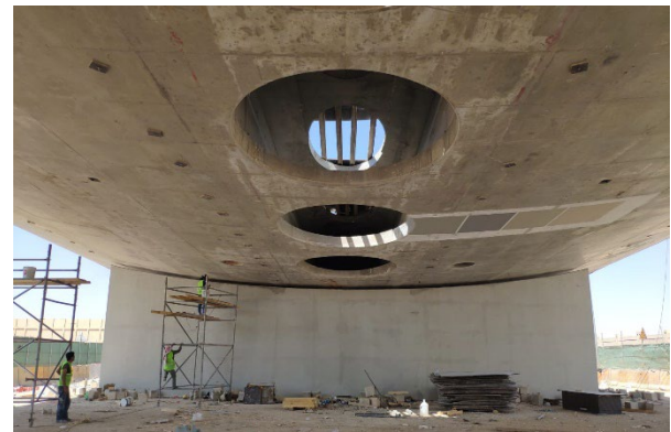
Figura 9. Aperturas para lucernarios.
