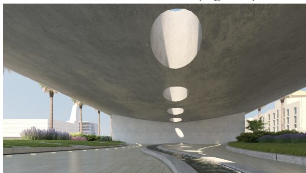
Figura 3. Vista inferior del tablero con los lucernarios centrales.
