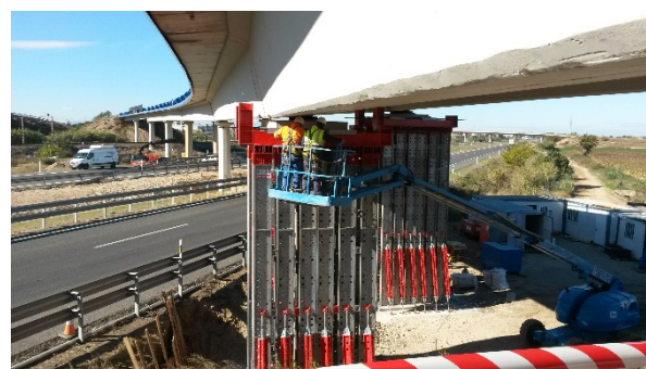
Figura 8. Vista de torres auxiliares montadas en los dos fustes de la pila 1.
