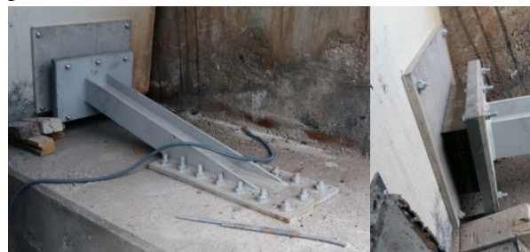
Figura 6. Tope lateral provisional y detalle de este en zona de viga artesa.
