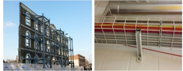
Figura 2. Aplicaciones de anclajes en mampostería
