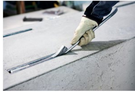
Figura 1. Carril embebido antes de la instalación (izquierda) y después de la misma (derecha)
