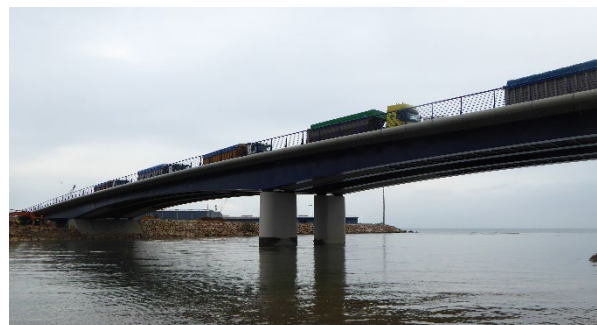
Figura 18. Prueba de carga en calzada
