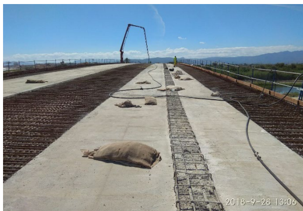
Figura 14. Losa hormigonada en primera fase.
