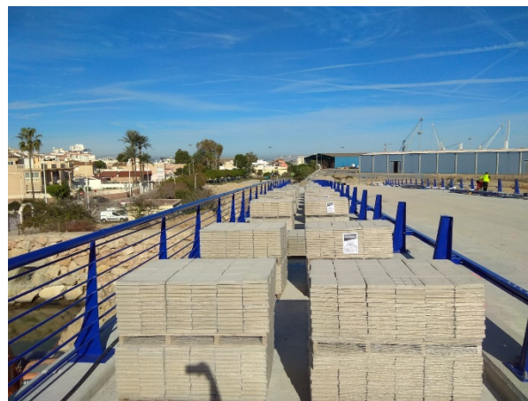
Figura 17. Prueba de carga en la zona peatonal y carril ciclista.
