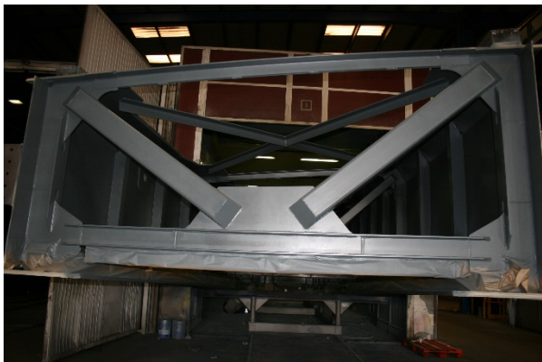
Figura 9. Vista de una celosía de la zona de negativos en taller.
