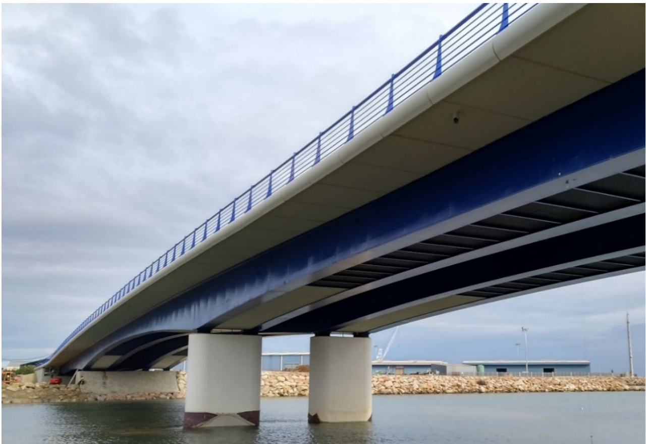
Figura 5. Vista general del Viaducto sobre el río Serpis
