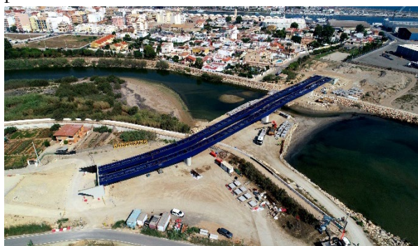
Figura 15. Vista aérea de las 4 vigas colocadas en obra.
