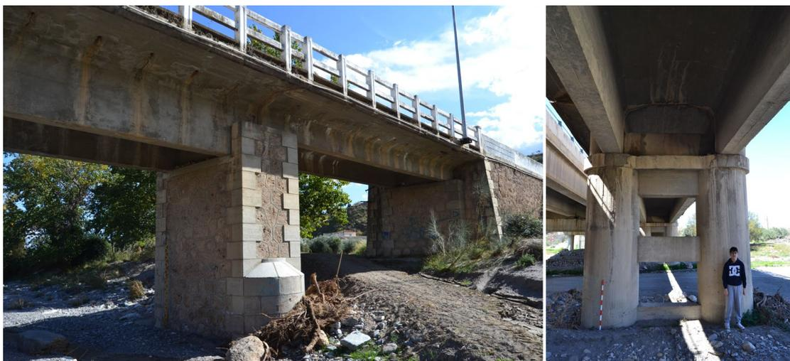
Figura 7. Puente números 1 y 2 sobre el río Almanzora. Detalles de las pilas. Fotografía del autor
