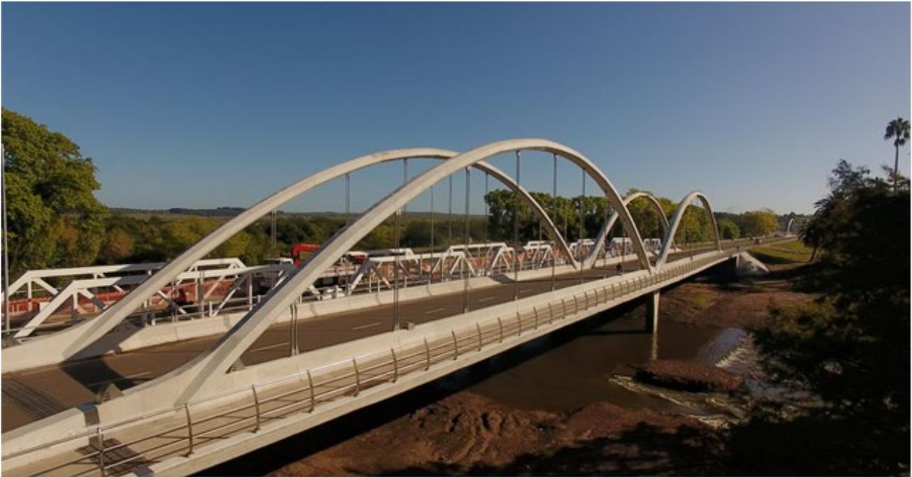
Figura 1. Aspecto final de los puentes. En primer plano, el puente de 112.15 m de longitud. Al fondo se aprecia el puente de 55.0 m de longitud.
