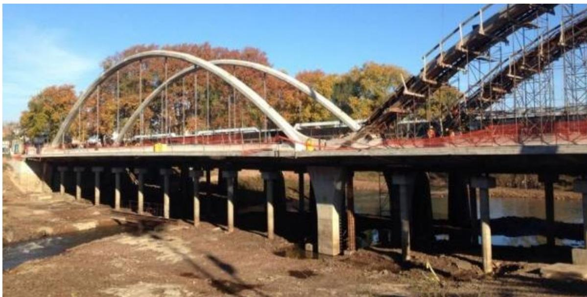
Figura 9. Aspecto de los puentes durante la ejecución de la obra, en la que se pueden apreciar los pilares provisionales.
