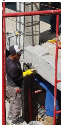
Figura 9: Refuerzo a cortante de las vigas durante su aplicación
